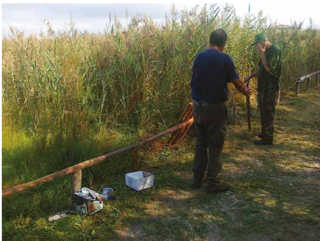
Realizzazione di nuove staccionate con pali di castagno.
