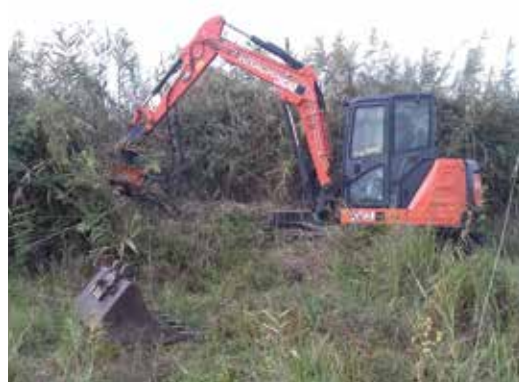
Un mezzo meccanico, fornito dal Comune di Cerveteri, prima trincia il canneto e poi costruisce un argine laterale all'area di rispristino ambientale di Stallonara. Servirà ad impedire che l'acqua immessa nel nuovo invaso dall'Ente gestore fuoriesca dai prati allagati e si disperda verso il nucleo centrale della Palude di Torre Flavia.
