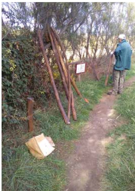
Si preparano i pali di castagno (trattati e scortecciati per mantenerli più a lungo) per le staccionate.
