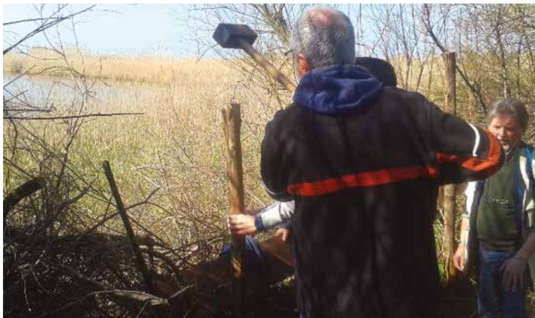
Si costruiscono i capanni di osservazione: dapprima si collocano pali e tavole come supporto per i rotoli di incannucciata.
