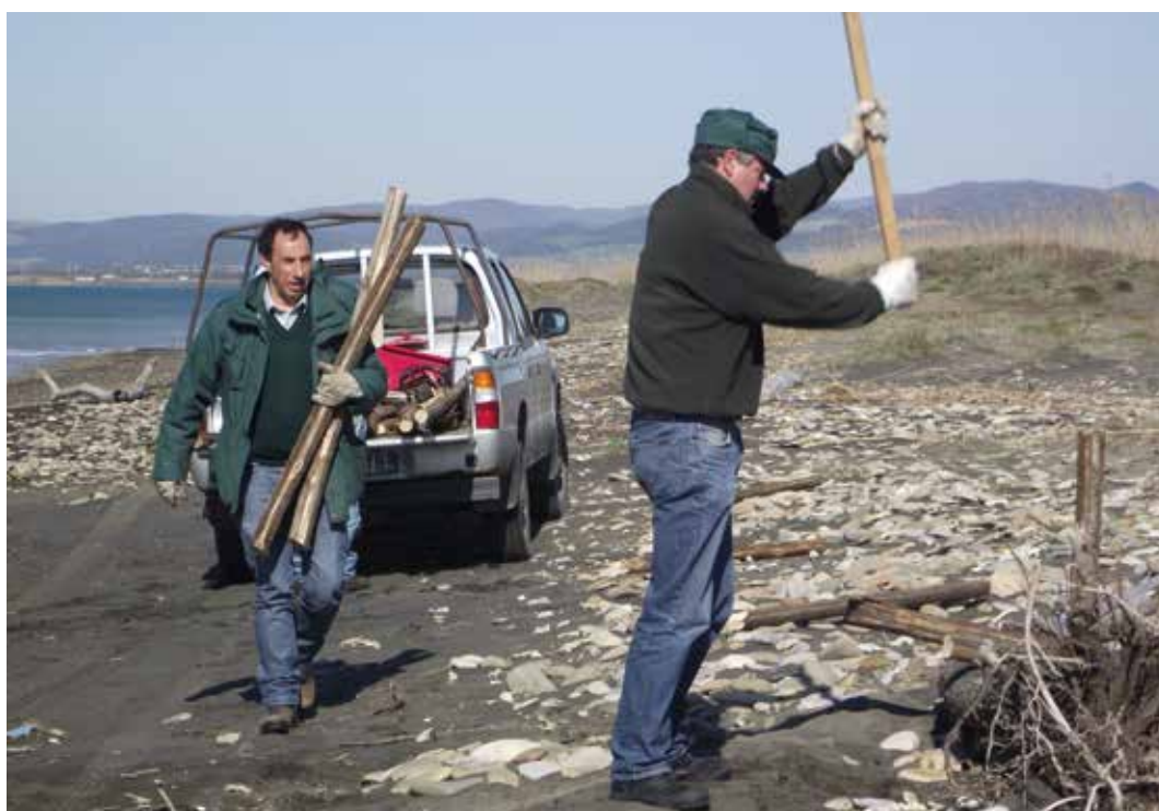
Diverse fasi della preparazione della recinzione con pali di castagno (da effettuarsi in anticipo rispetto alla stagione di nidificazione; es., primi di marzo) presso la Spiaggia del Corriere piccolo. Per trasportare i materiali è necessario un mezzo fuoristrada. La presenza di sassi può rendere molto difficoltosa la collocazione dei pali.
