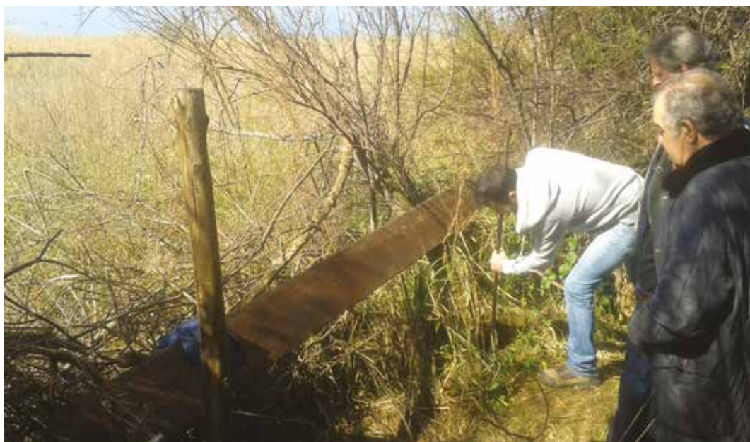
Uso della cartoccia a mano per realizzare il foro nel quale verrà collocato il palo di castagno a supporto della staccionata.
