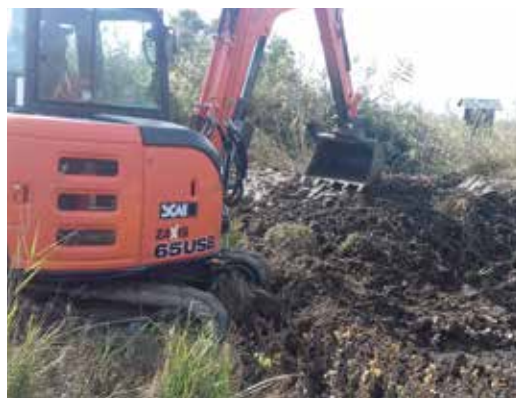
Un mezzo meccanico, fornito dal Comune di Cerveteri, prima trincia il canneto e poi costruisce un argine laterale all'area di rispristino ambientale di Stallonara. Servirà ad impedire che l'acqua immessa nel nuovo invaso dall'Ente gestore fuoriesca dai prati allagati e si disperda verso il nucleo centrale della Palude di Torre Flavia.
