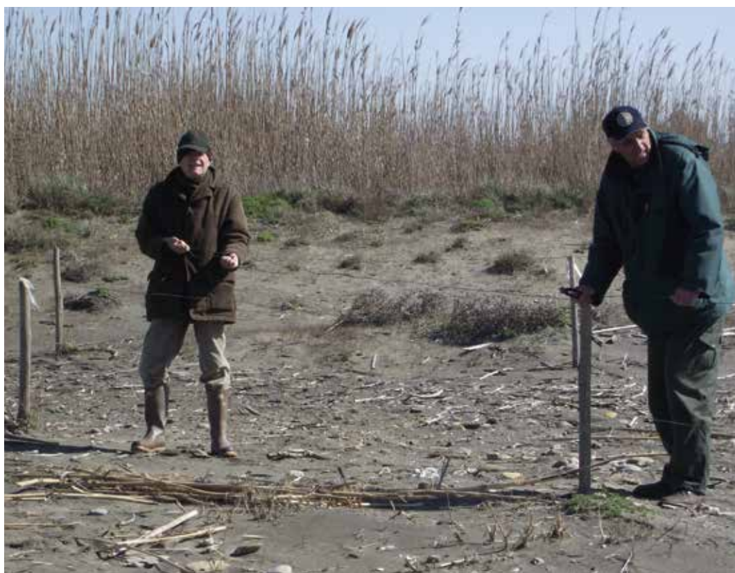
Pali di castagno appena posizionati. Tra i pali può essere steso un filo metallico (che va adeguatamente segnalato) oppure una corda marinara bianca più visibile.
