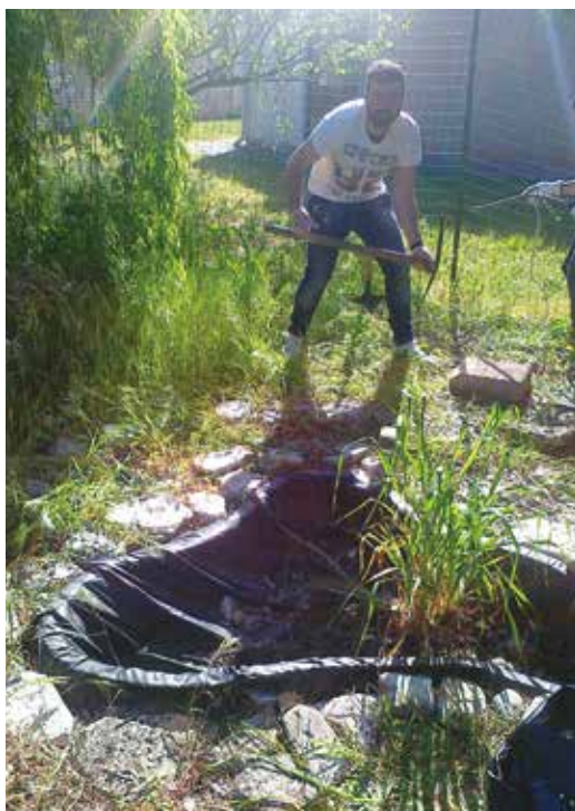
La costruzione di un piccolo stagno in una scuola, con l'aiuto di studenti di Ingegneria: dopo lo scavo è stato inserito uno stampo prefabbricato e uno strato di plastica nera. Le piante utilizzate sono state raccolte nella Palude di Torre Flavia così da ricreare un ambiente analogo.
